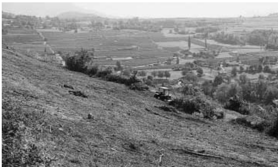
Vignoble de Jongieux (Savoie) : débroussaillage avant replantation du coteau de Marestel
