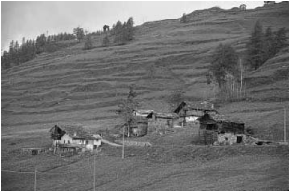
Caillaz (Chamois). Un aménagement rigoureux des sols : à l'amont, les anciens champs terrassés dédiés aux cultures sèches, à l'aval, les prés irrigués.
