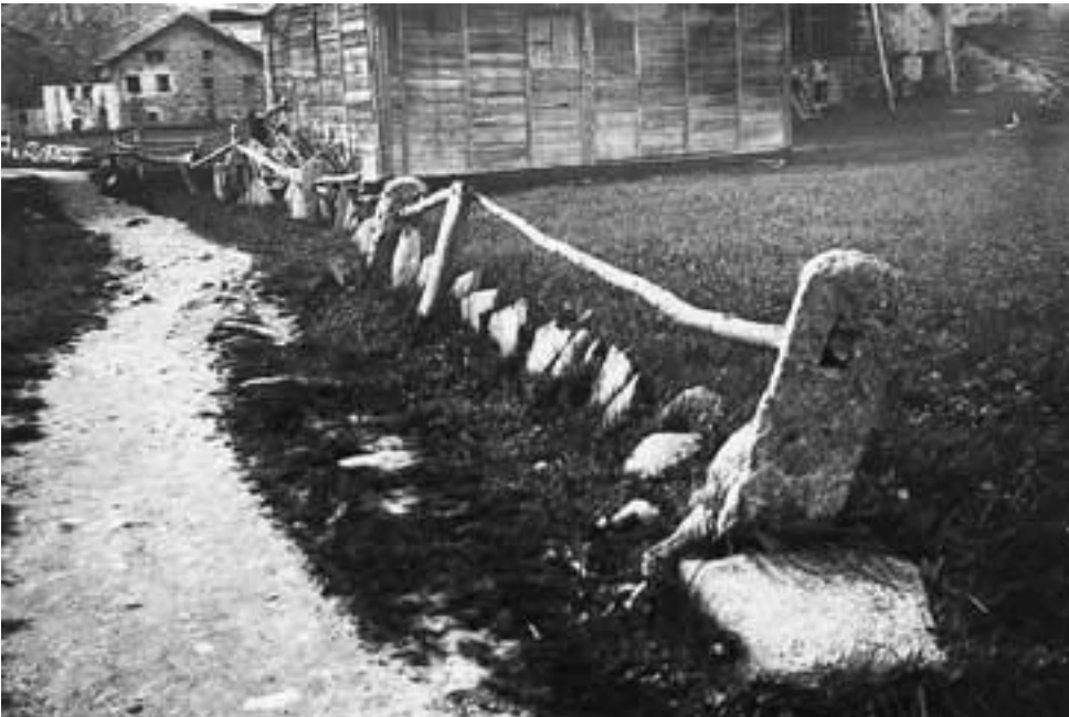
Gressoney-La-Trinité. Une rampe de protection abandonnée
